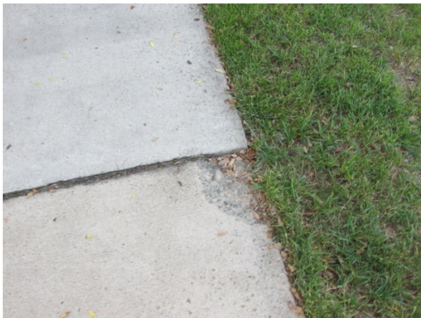
Edge deterioration
